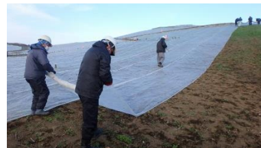
シート撤去作業の様子（2023年2月3日撮影）
