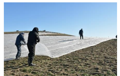
シート撤去作業風景（2022年2月9日撮影）
