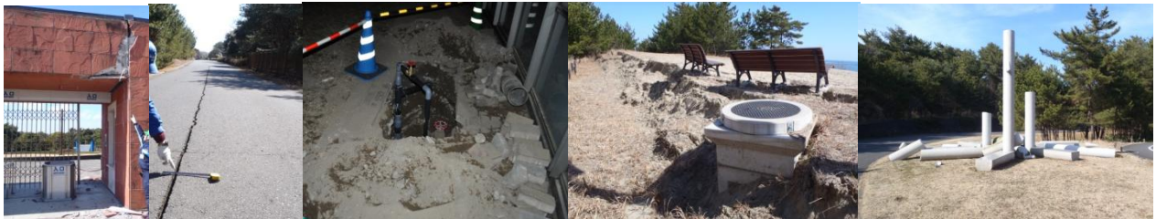
震災による園内の被害状況の一部
