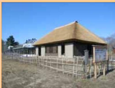
平成22年3月11日撮影 手前に主屋、奥に隠居屋
