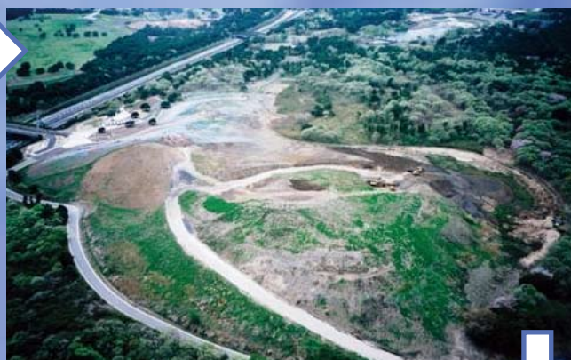
造成工事中の「みはらしの丘」
