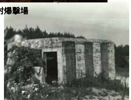
着弾確認の見張りの待機所
