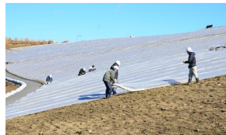
シートの敷設作業 撮影/2016年12月17日
