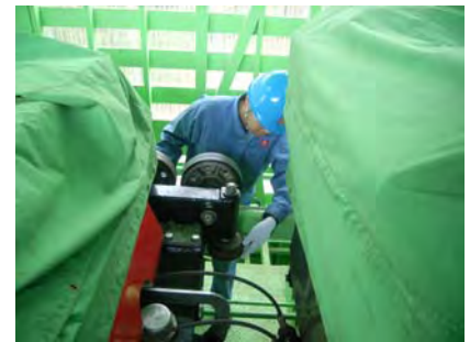
定期的な施設点検
