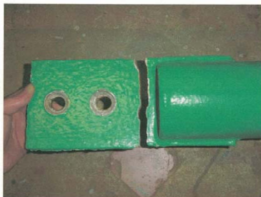
(参考写真) 破断した「あて板」
