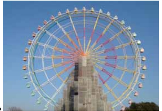
左側半分が塗替え後、右側半分が塗替え前 (平成19年1月30日撮影)
