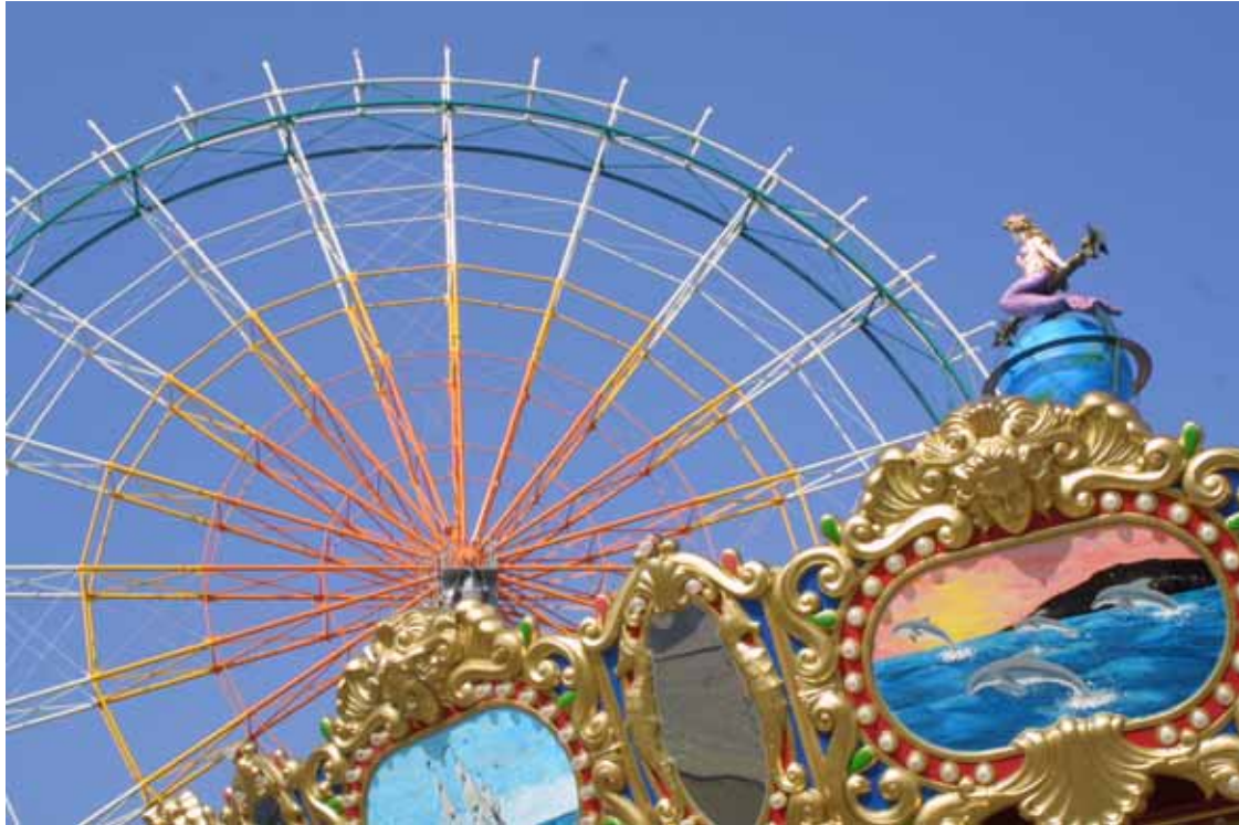
お色直しも終わり、後はゴンドラの設置を残すのみとなった大観覧車「プリンセスフラワー」 (平成19年3月4日撮影)
